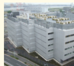
Tokyo No. 4 Data Center (Koto Ward, Tokyo)
