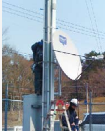
衛星回線を用いた基地局復旧
