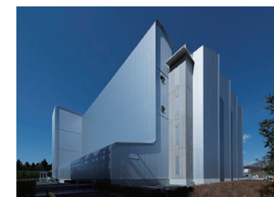
白河データセンター
