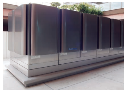
産業用燃料電池発電システム Bloomエナジーサーバー
