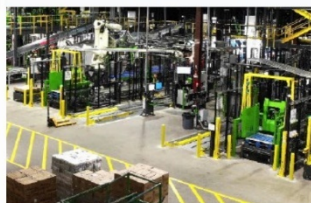
ケース品自動倉庫
