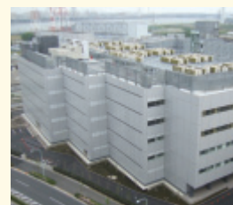
東京第4データセンター(東京都江東区)
