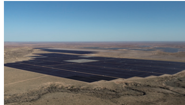
Juno solar power project (Texas, USA)
